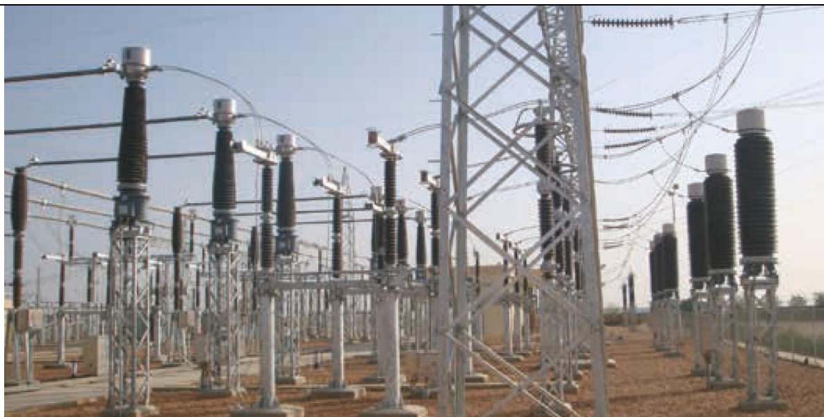
Obrázek 32: Příklad instalace měřicích transformátorů proudu firmy Arteche
